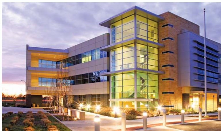
大型HVAC应用
