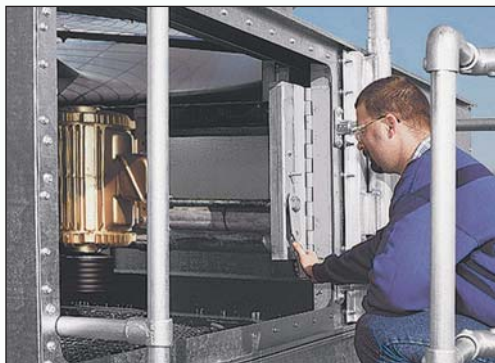
电动机在内部
