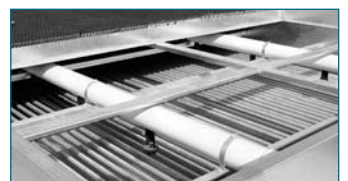
可移开脱水器来检修盘管
